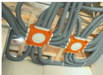
Instalacja R-VENT Flex na stropie przygotowana do ukrycia w warstwie izolacji.
