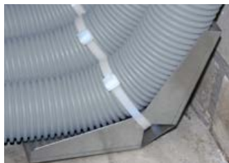
Prowadzenie instalacji R-VENT Flex w narożniku pomieszczenia.
