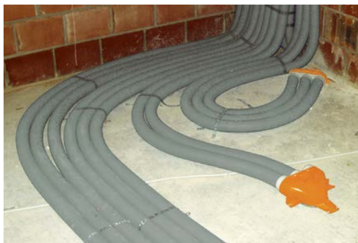
Instalacja R-VENT Flex na stropie przygotowana do ukrycia w warstwie izolacji.
